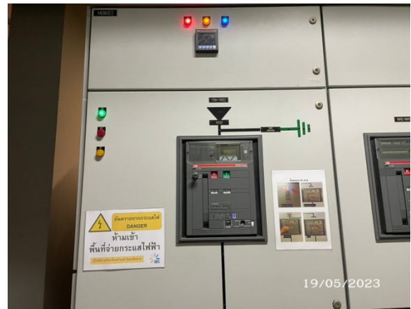
รูปที่ 2-27 ชุด Power Monitoring บริเวณตู้ MDB
