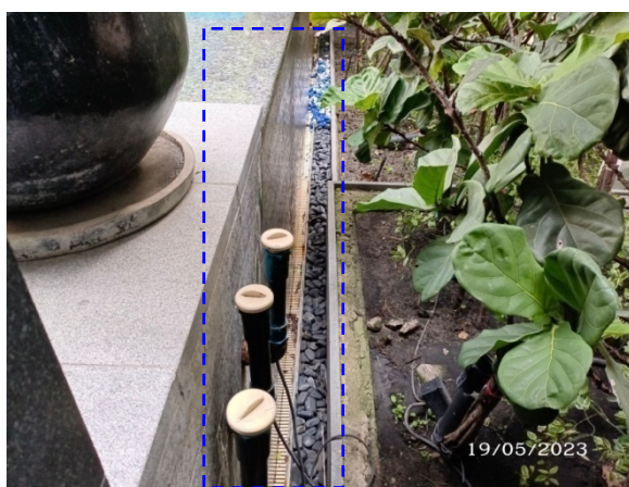
รูปที่ 2-39 รางระบายน้ำล้นรอบสระว่ายน้ำ
